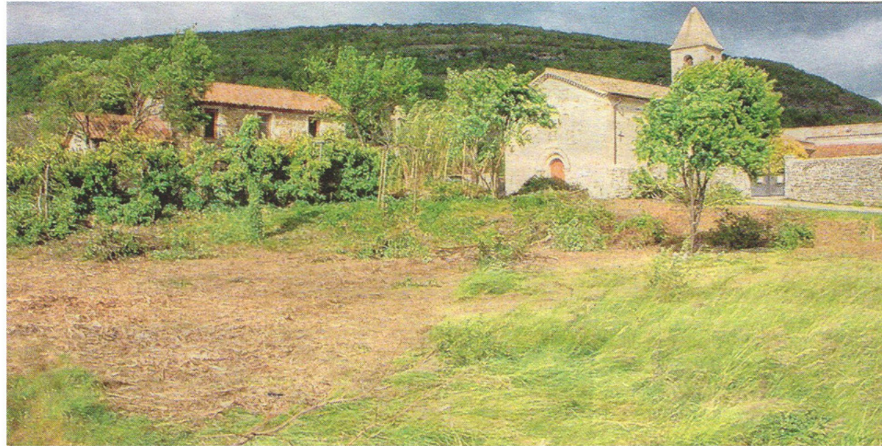
Le futur jardin du presbytère en voie de rénovation.
